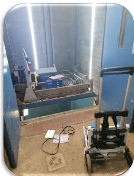
Montage der Kabinensprechstelle und Herstellung der notwendigen Verdrahtung auf dem Kabinendach
