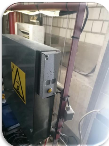
Sprechstelle auf dem Kabinendach mit integriertem Notruftaster, um vom Kabinendach die direkte Sprechverbindung zur Leitstelle herzustellen
