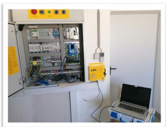
Installation des LiftGate IP Gateways von 2N
